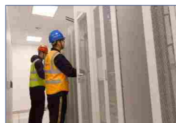
车站机电设备检修
