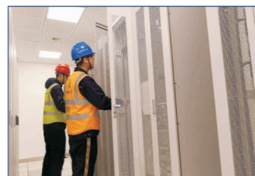
车站机电设备检修
